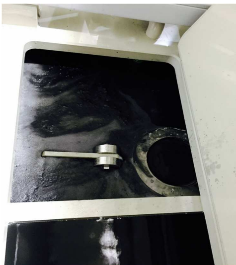
Schwimmskimmer innerhalb eines Entfettungsbades
